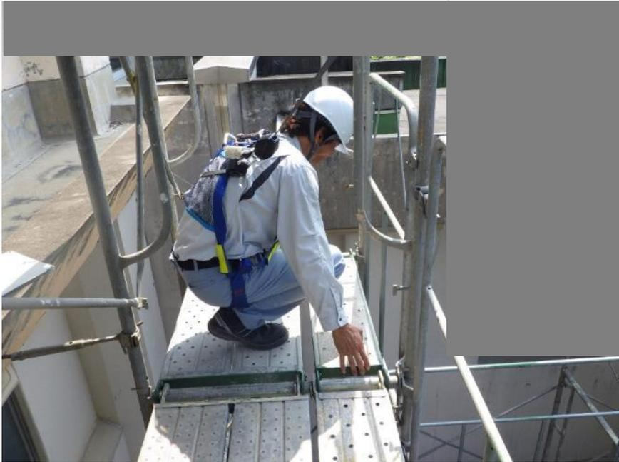
※5層目で作業中、妻側から墜落、3層目の床へ墜落した後、地上まで墜落。
